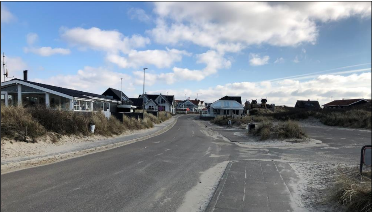
Figur 1. Vejers Havvej ud for det eksisterende hotel, set mod øst.
