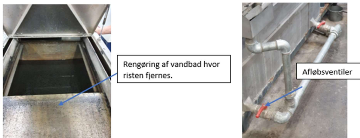
Figur 5 viser rist i vandkar og afløbsventiler.
