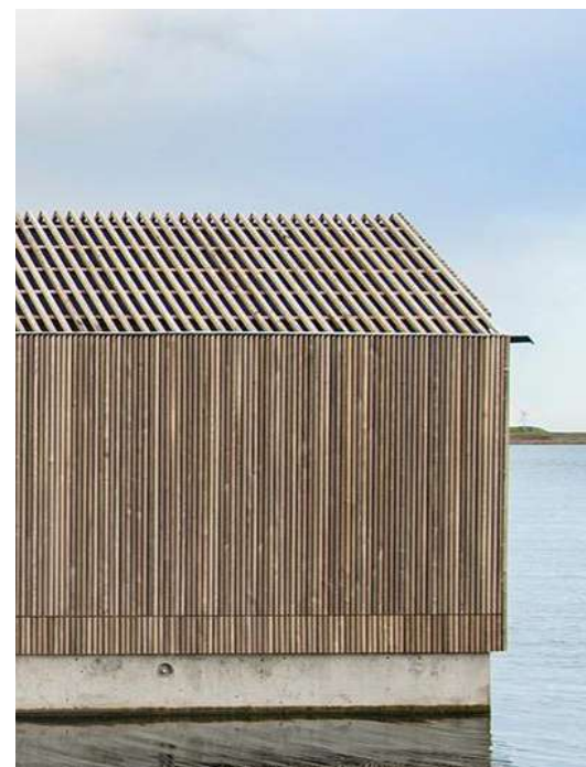
Beklædning med lameller i Thermo ask i et vandmiljø
