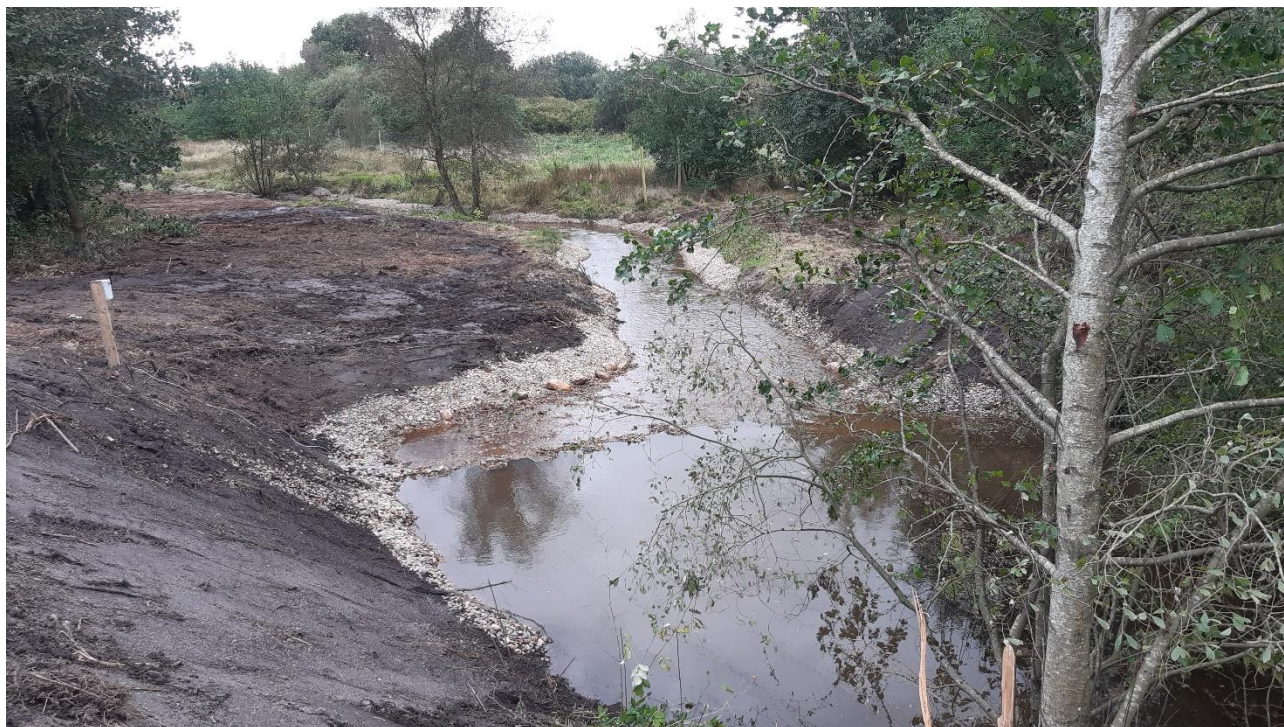
Figur 11 Spunsvæg og stryg der løfter vandspejlet nedstrøms jernbaneunderføringen.
