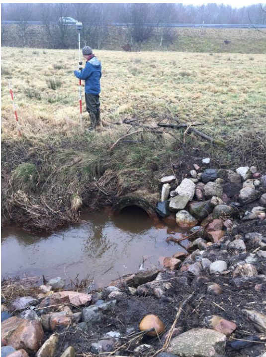
Figur 4. Spærring RIB-00910 indløb i rørlagt strækning, vest for underføringen ved Lundvej.
