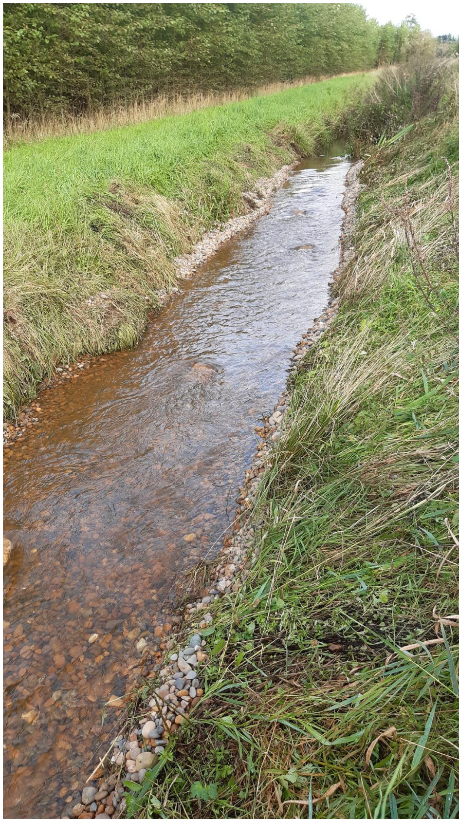
Figur 12 Et af 15 udlagte gydegrus stryg og med udlagte skjulesten.
