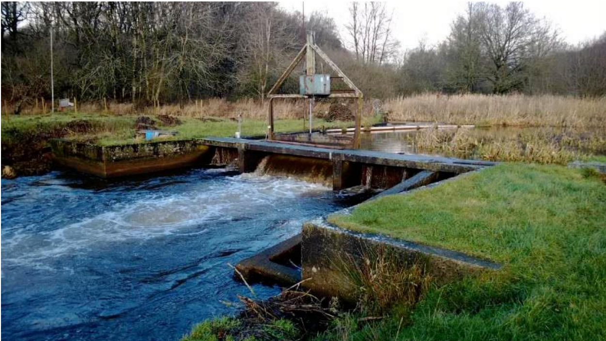
Figur 2 Stemmeværket, fisketrappen og i baggrunden indløbsbygværket
