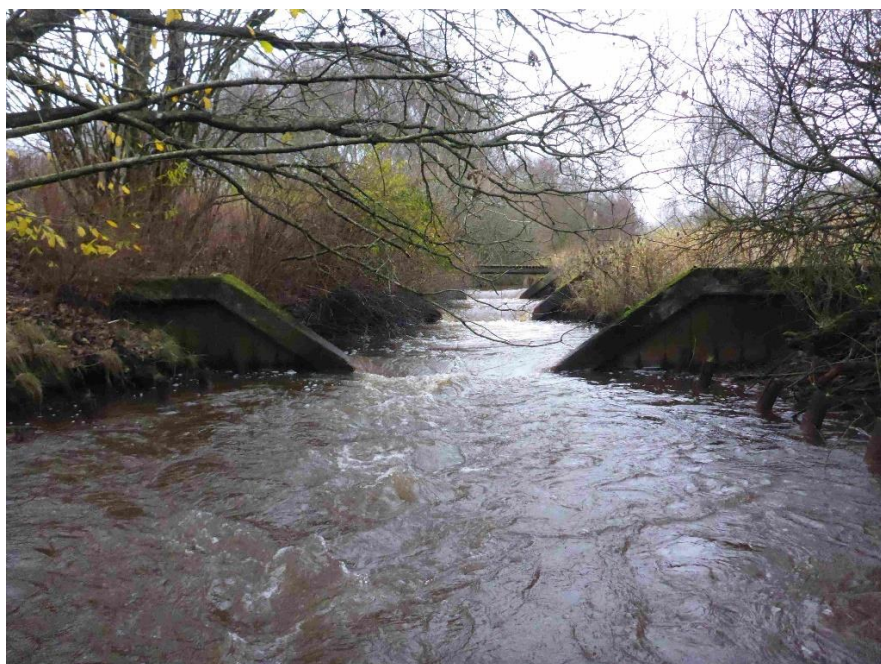
Figur 3 Betonstyrtet som udgør spærring RIB-01122
