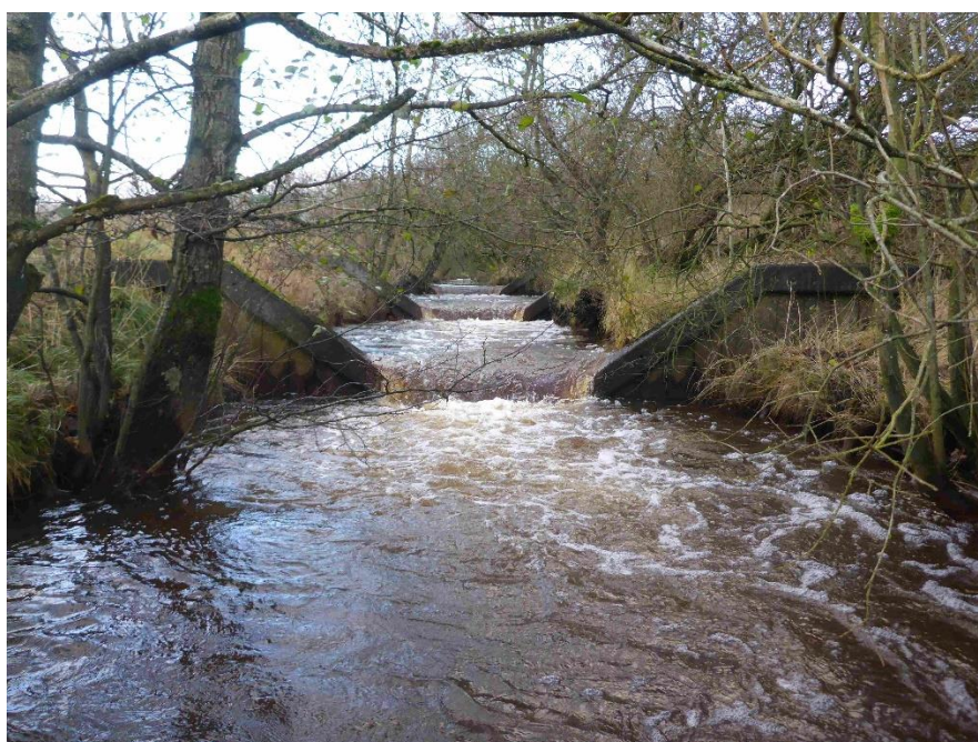
Figur 4 Betonstyrtet som udgør spærring RIB-01123.
