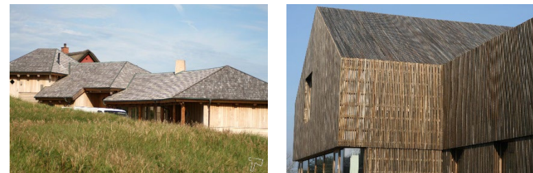
Figur 21: Eks. på hhv. træspån og trælister som tagbeklædning.
