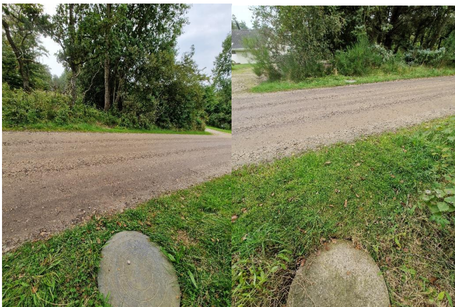
Figur 2 Billede af brønde ved Gl. Mælkevej på hhv. nordsiden (til venstre) og brønd på sydsiden (til højre).
