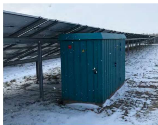
Foto - Eksempel på streng inverterer (TV) og eksempel på transformerkiosk med fordelingstransformerer (TH).
