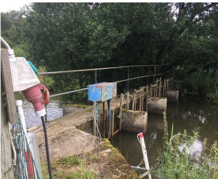
Figur 6. Stemmeværket i Alslev Å. Kun det øverste af stemmeværket fjernes (synligt på dette billede), mens betonbunden bibeholdes.
