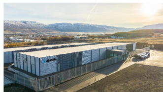
Eksempel på datacenter.
