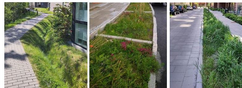
Eksempler på grøfter og grønne regnvandsbede.
