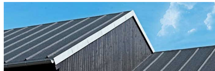
Eksempel på tagpap med listedækning
