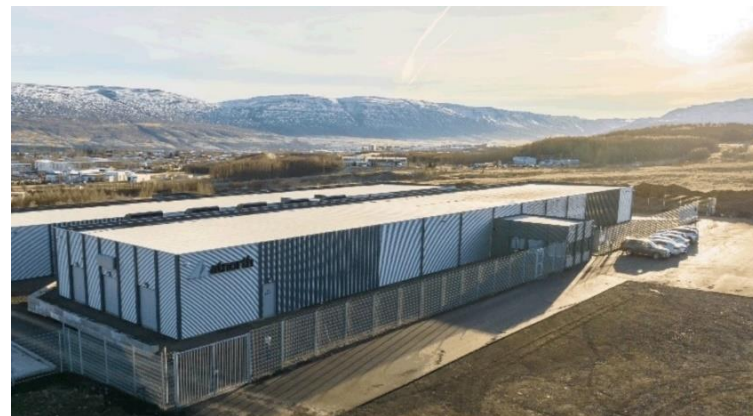
Figur 12: Eksempel på datacenter.
