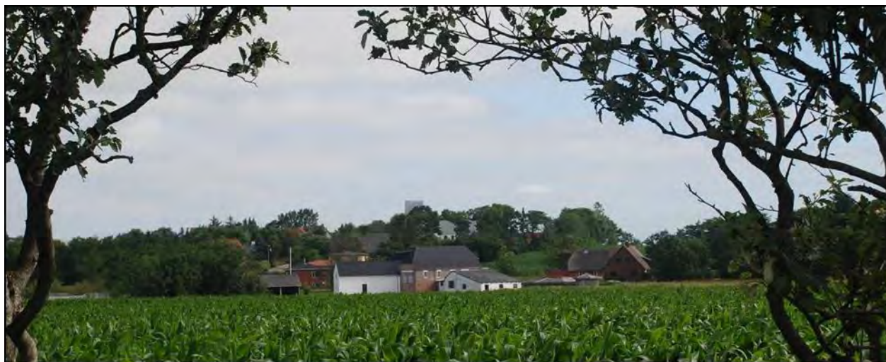
Figur 19-42: Kig til Lydum by mod nord. Kirken på toppen af dalsiden og vandkraftværket i forgrunden har haft stor betydning for landskabsudviklingen i ådalen. Det ses tydeligt på billedet, hvordan indkigget til kirken hindres af beplantningen.
