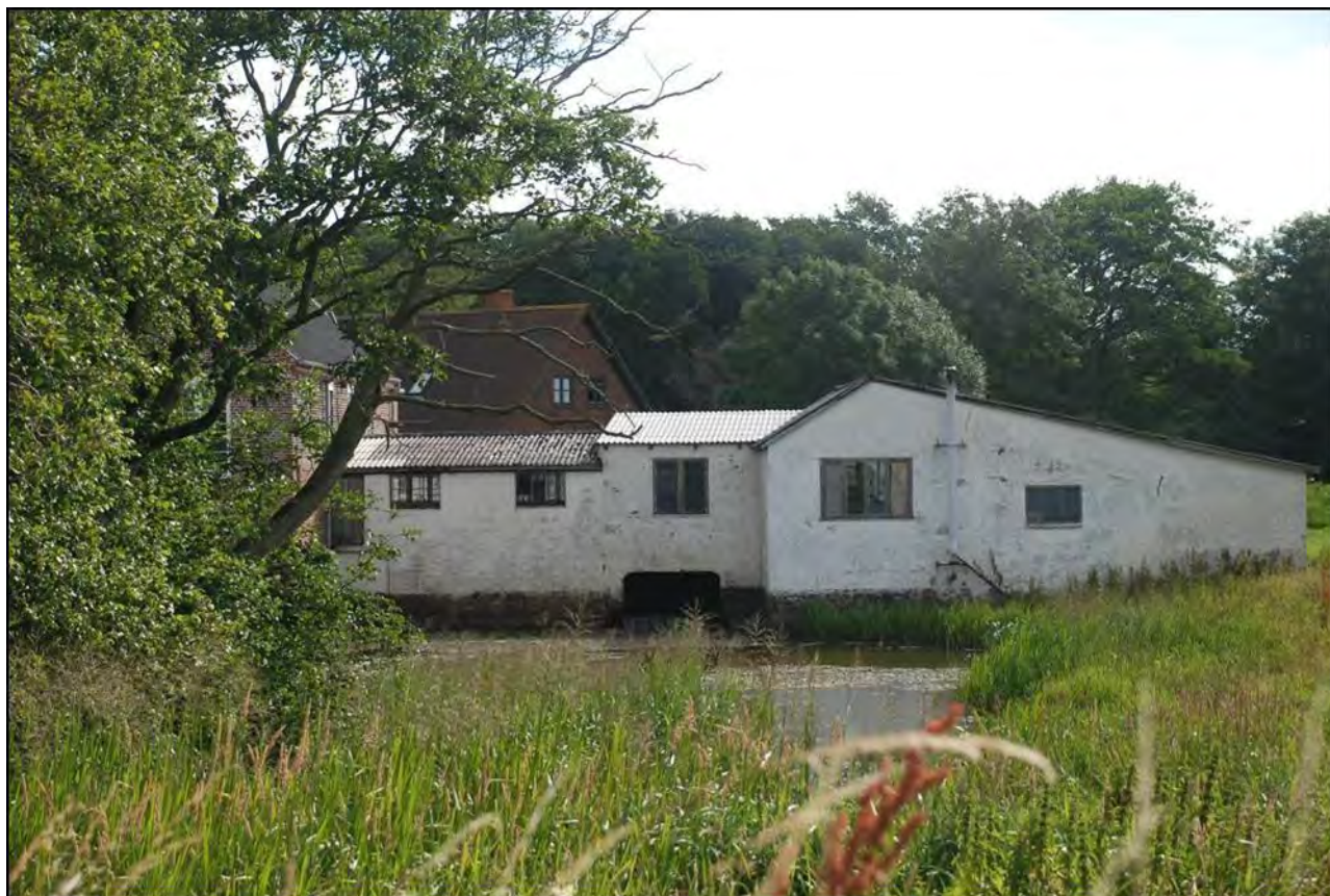
Figur 19-43: Det bevaringsværdige kulturmiljø, Lydum vandmølle/elværk i bunden af ådalen.
