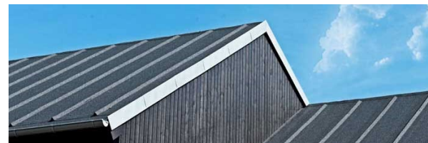
Eksempel på tagpap med listedækning
