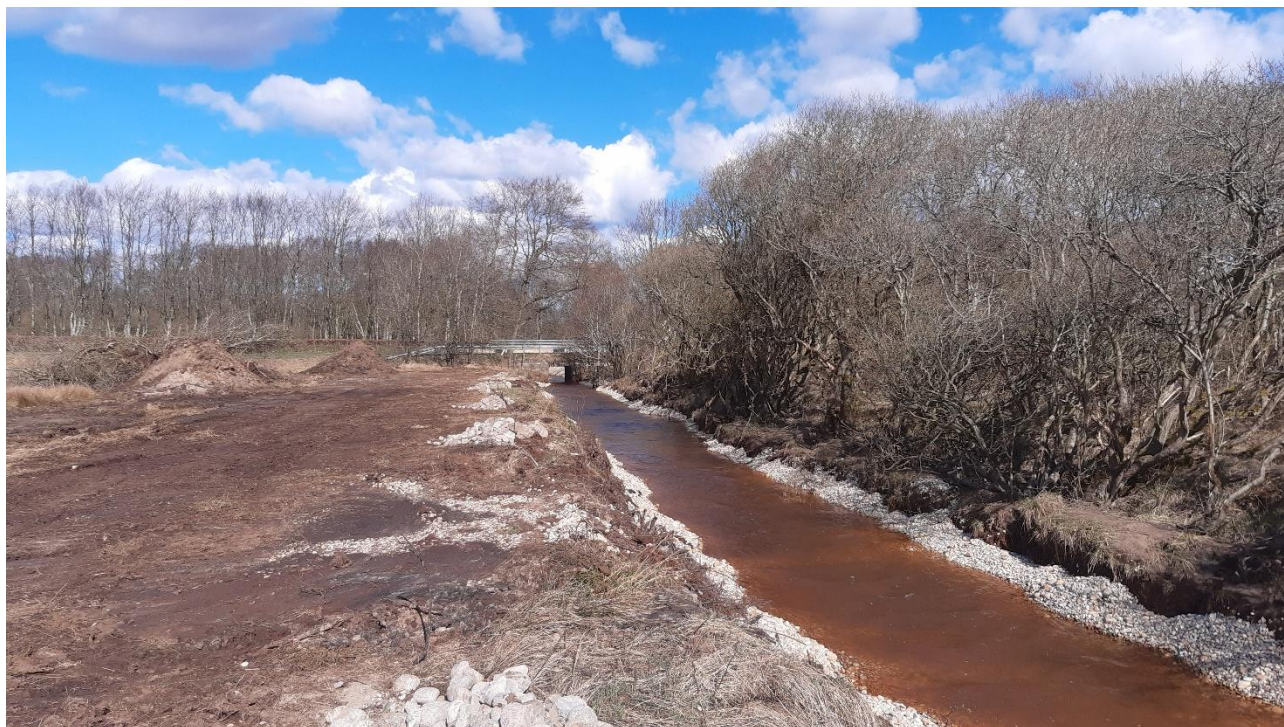
Figur 6. Efter fjernelse af RIB-01123 betonstyrterne (31. marts 2025). Her ses grusstryget fra position af det fjernede betonbygværk og i opstrøms retning mod Roustvej. Stryget er i alt ca. 200 meter langt for at udjævne vandspejlsfoldet og ligger med et vandspejlsfold på ca. 5 promille. Bunker af skjulesten ligger klar på kronekanten til udlægning, som senere blev udført af frivillige sportsfiskere fra Varde Å sammenslutningen.
