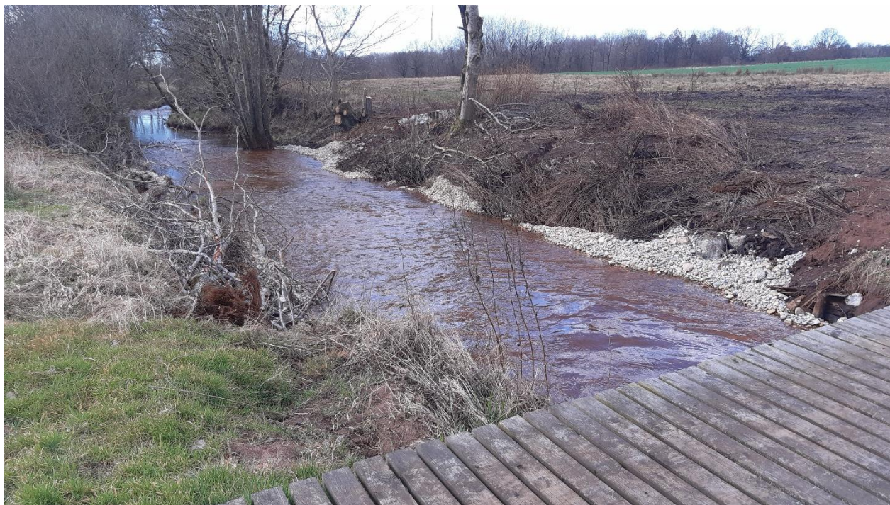
Figur 5. Efter fjernelse af RIB-01122 betonstyrte, set i nedstrøms retning. Her ses det øverste af de 4 grusstryg som udligner vandspejlsfaldet. Strygene ligger med et fald på 4,5 promille.
