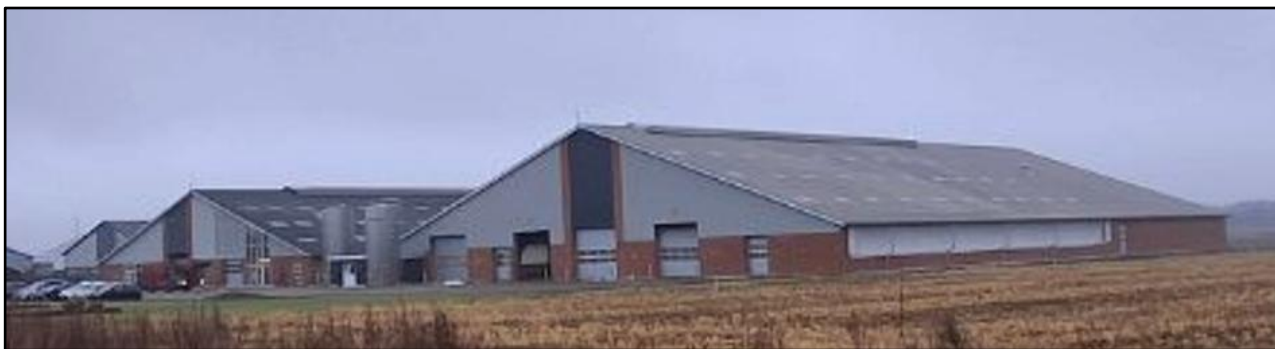
Figur 6. Vestvendt gavlfacade af eksisterende velfærdsstald med malkecenter (bygning 23). Foto fra ansøger.
