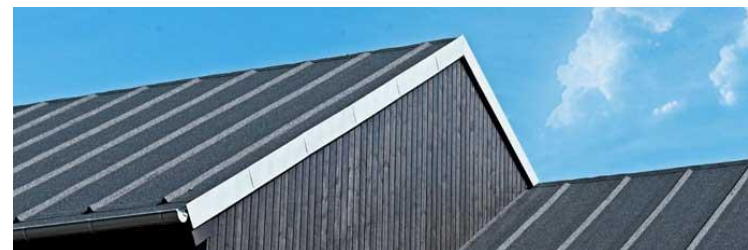
Eksempel på tagpap med listedækning
