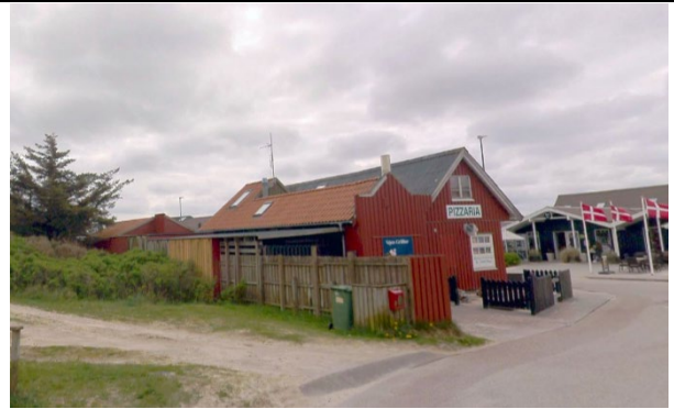
vest facade foto:7/5-2024
