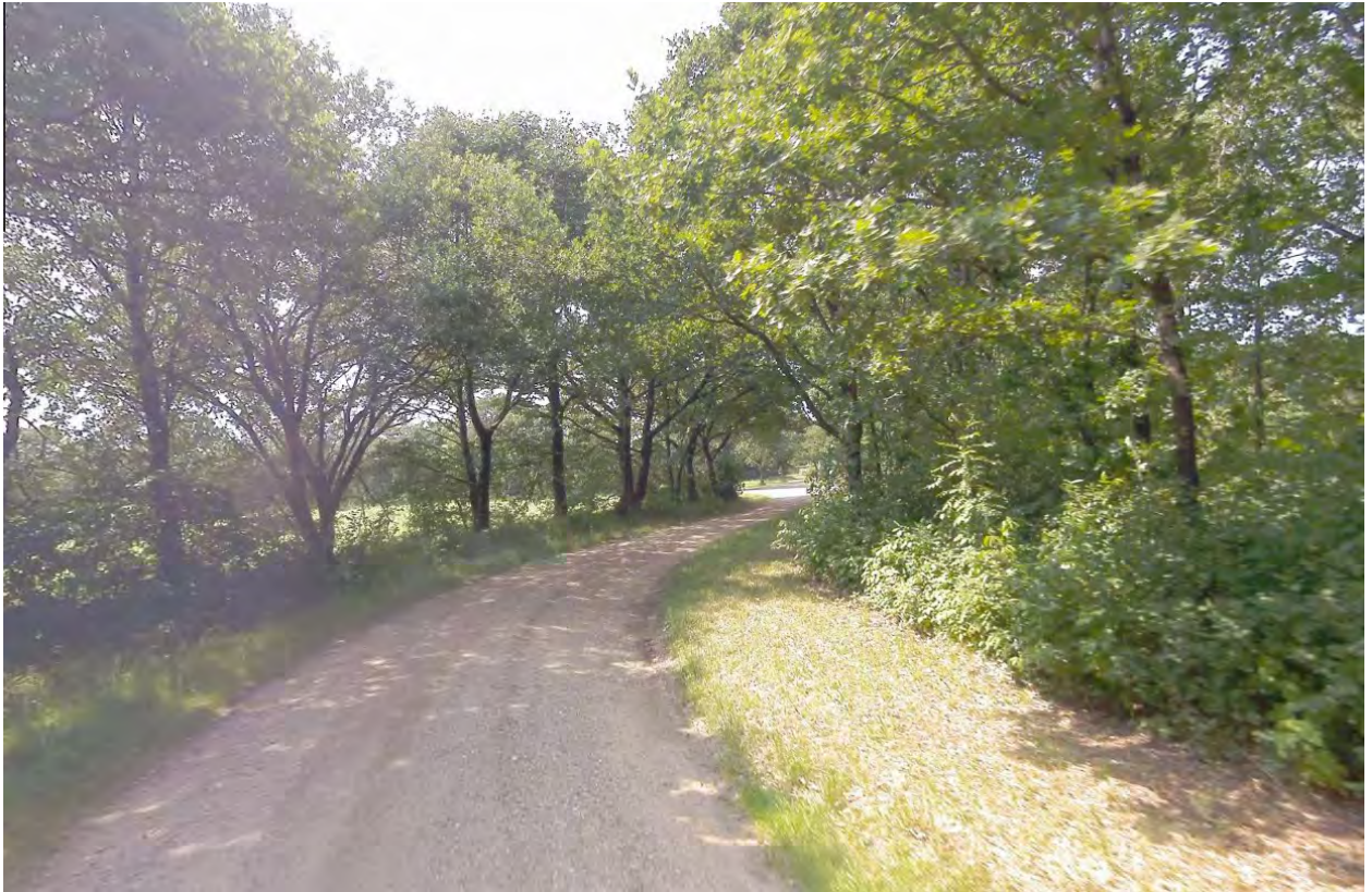
Figur 4 Plantagevej er en kommunevej med grus og er ca. 3-4 m bred igennem Ølgod Kommunes Plantage.
