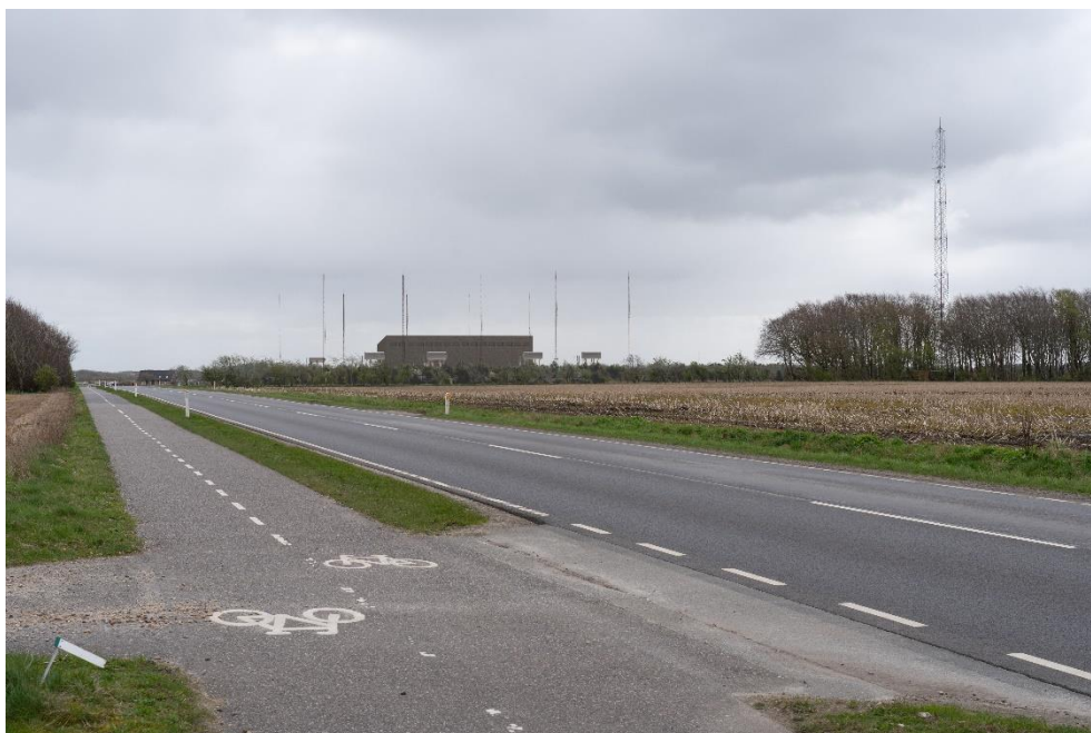
Figur 7-17 Efter-situationen ved kompenseringsstationen ved Hennebjerg med afskærmende beplantning. Set fra visualiseringspunkt 1 - Nymindegabvej Nord.
