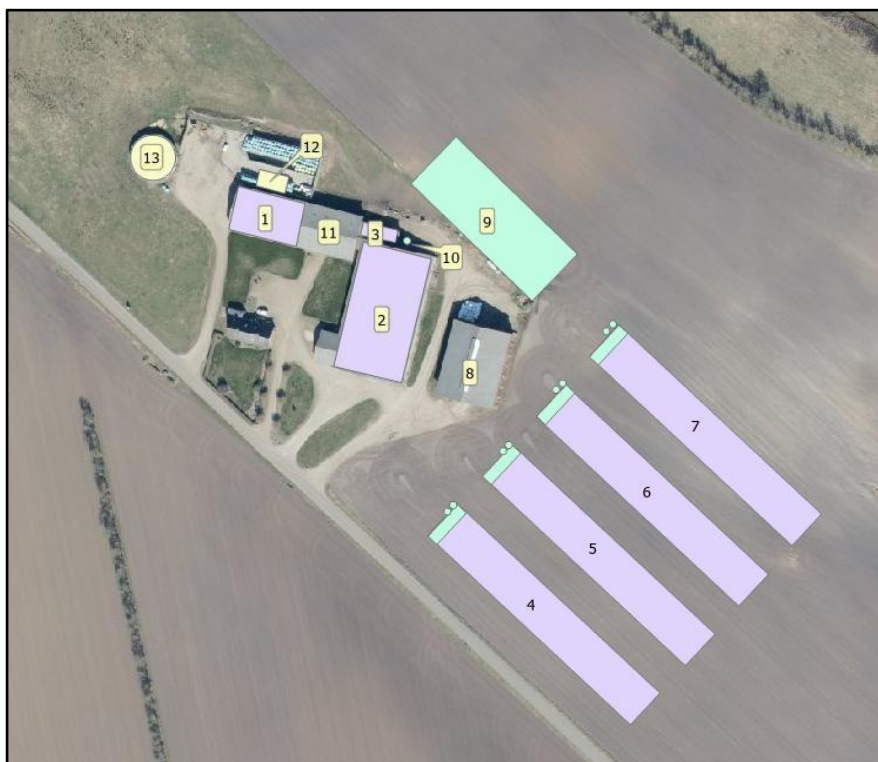
Figur 9. Oversigt over husdyrbrugets bygninger.
