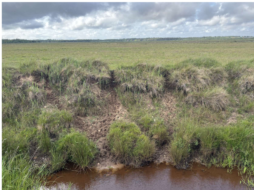
Figur 3. Eksempel på kronvildtets nedtrampning af Ringdiget omkring Petersholm Inddæmningen, set mod nord ud over inddæmningen i juni 2025.
