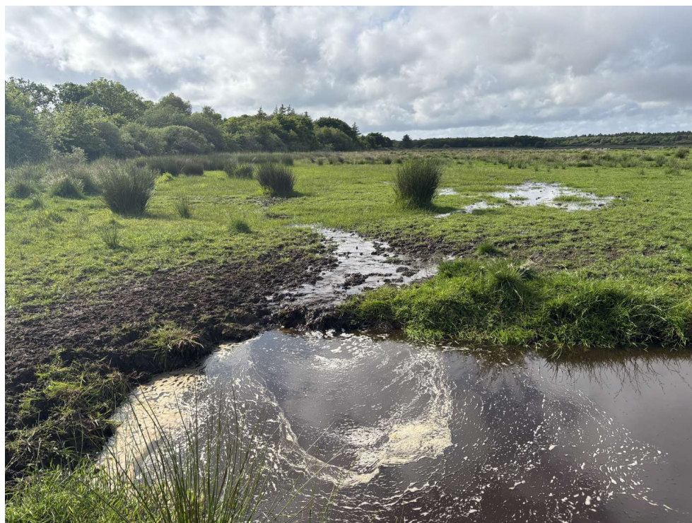
Figur 9. Vandet fra digebruddet i Ringdiget løber allerede i dag igennem den indvendige digegrøft i baggrunden og der fra videre ud over terræn ned i en af afvandingskanalerne i Petersholm Inddæmningen i forgrunden, som set i juni 2025.
