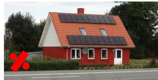
Figur 17. Eksempel på hvordan solcellepaneler er nedfældet i tagfladen, i plan med tagoverfalden og placeret harmonisk, så der er balance i tagfladen.
