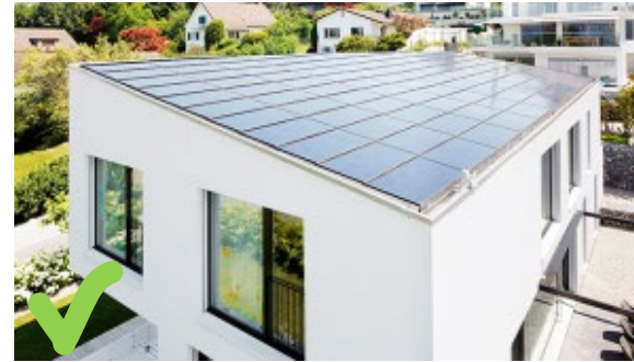
Figur 16. Eksempel på en harmonisk placering, i plan med tagmaterialet.
