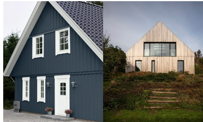
Figur 20. Eksempel på vinduer med bred karm, og rammer, som ikke har et enkelt udtryk samt eksempel på vinduer, hvor udtryk fremstår enkelt.
