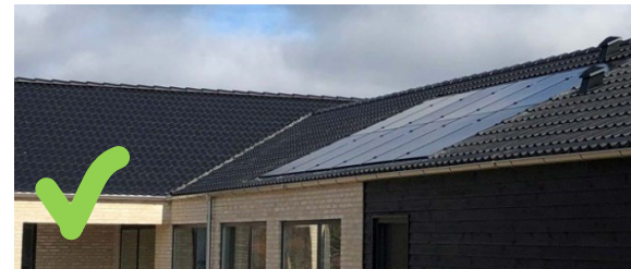
Figur 17. Eksempel på hvordan solcellepaneler er nedfældet i tagfladen, i plan med tagoverfalden og placeret harmonisk, så der er balance i tagfladen.
