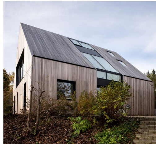
Figur 14. Eksempel på tag med trædækning, som fremstår med ubehandlede trælister.
