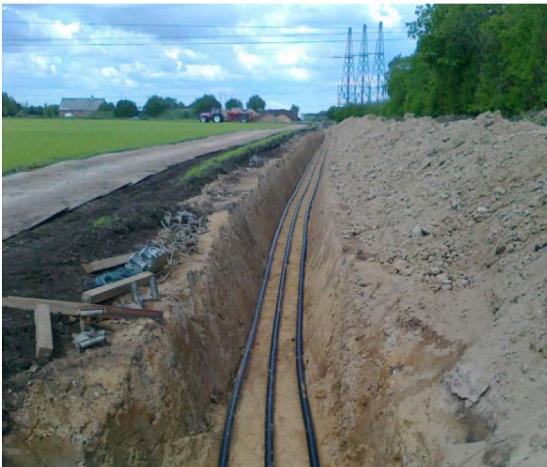
Figur 2-5 Eksempel på kabelgrav (enkelttracé) med køreplader til venstre og jordoplæg til højre.
