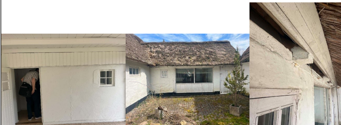
Østlig tilbygnings gavl mod syd / Østlig tilbygnings facade mod vest / østlig tilbygning – rem og spær-ender under stråtag
