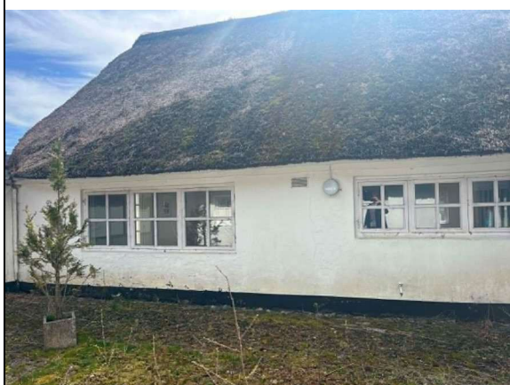
sydlige længes facade mod nord mod det indre gårdrum
