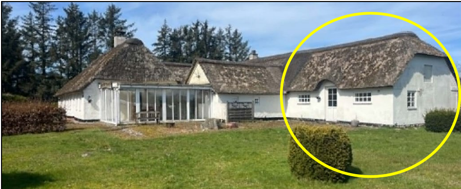
Nordlig længes syd facade og øst gavl
