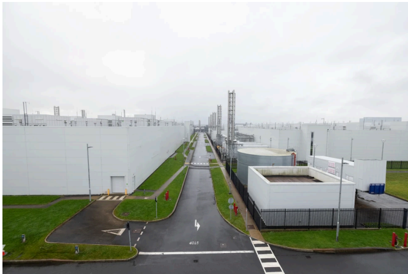
Microsofts Grange Castle datacenter i Dublin i Irland understøtter både cloud og AI. (Foto: Naoise Culhane Photography / Naoise Culhane)
