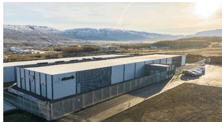
Figur 12: Eksempel på datacenter.
